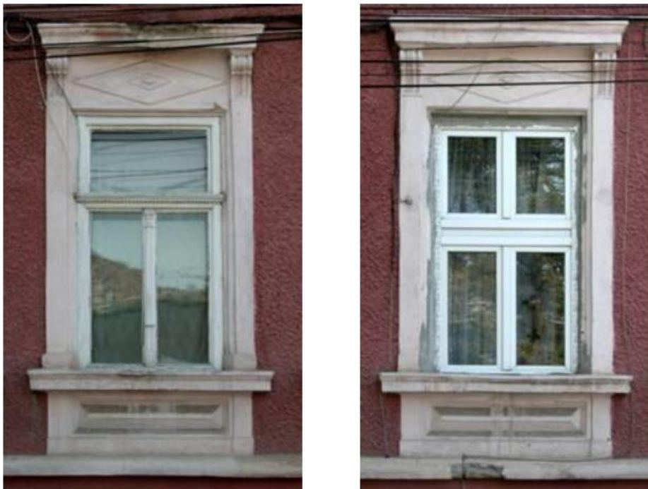
Egy jellemző „T” osztásos kapcsolt gerébtokos faszerkezetű ablak és műanyag utánzata
