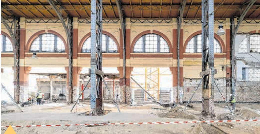
A tartóoszlopok alsó felét a fertőtlenítésre használt klórtartalmú szerek is megkezdték
