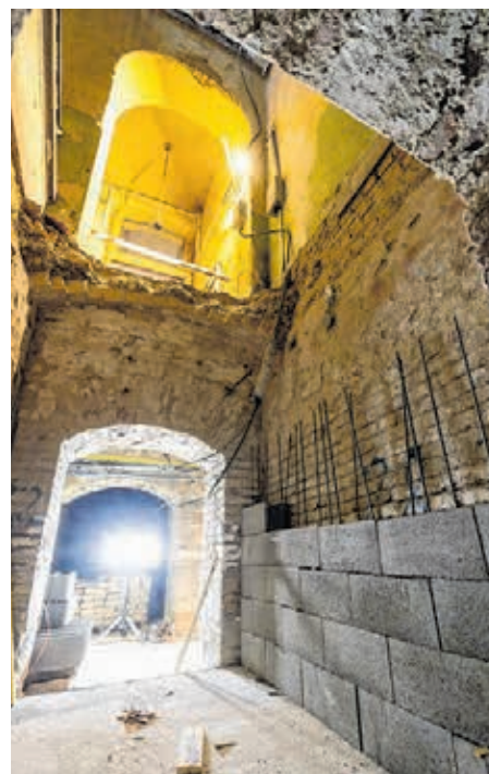
Már alapozzák a liftaknát a Hunyadi téri fejépület lépcsőházában
