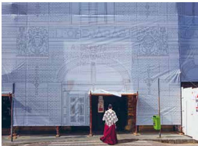
Bárdos Tamás Csarnok felújítás alatt című képe.
