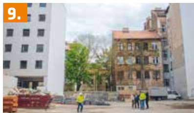
9. KÖZÖS ÜGYEINK Értékes telekkel gazdagodott Terézváros
